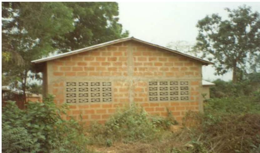
Il suffit d'avoir une aulacoderie qui soit peu coûteuse mais construite en matériaux durables, facilement prolongeable en cas d'extension et bien ventilée (ouverture opposée aux vents dominants et bonne circulation de l'air à l'intérieur du bâtiment). La porte d'entrée de l'aulacoderie doit s'ouvrir vers l'intérieur pour ne pas faciliter d'éventuelles échappées d'aulacodes. Les aulacodes peuvent être élevés en cages hors-sol (cages individuelles ou cages de groupe) ou en enclos au sol.
